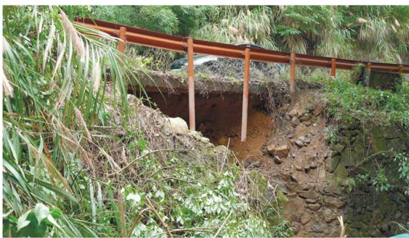
杜泽镇灰线沿线部分路段水毁塌方,路基受损。
